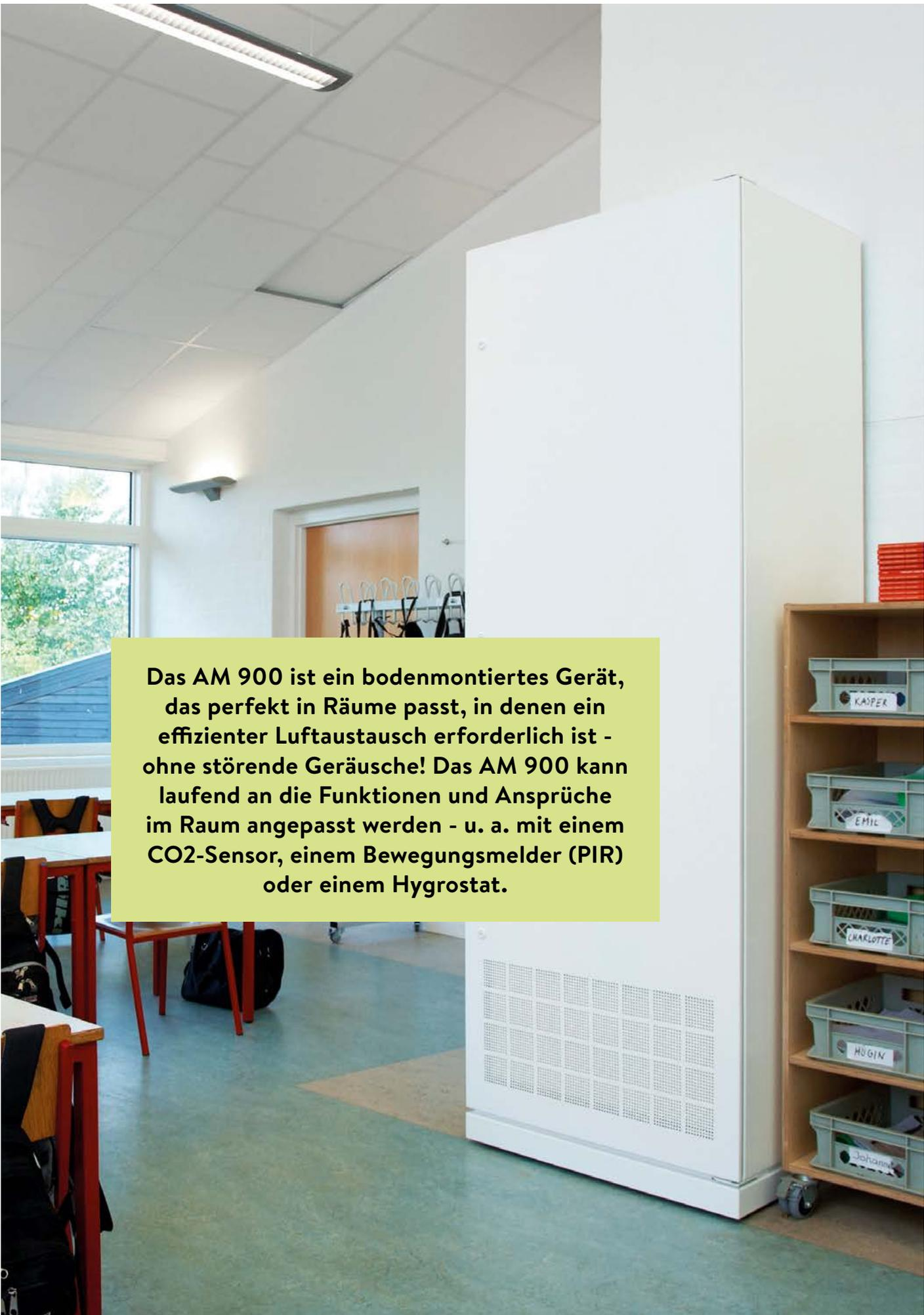
**Das AM 900 ist ein bodenmontiertes Gerät, das perfekt in Räume passt, in denen ein effizienter Luftaustausch erforderlich ist - ohne störende Geräusche! Das AM 900 kann laufend an die Funktionen und Ansprüche im Raum angepasst werden - u. a. mit einem CO<sub>2</sub>-Sensor, einem Bewegungsmelder (PIR) oder einem Hygrostat.**
